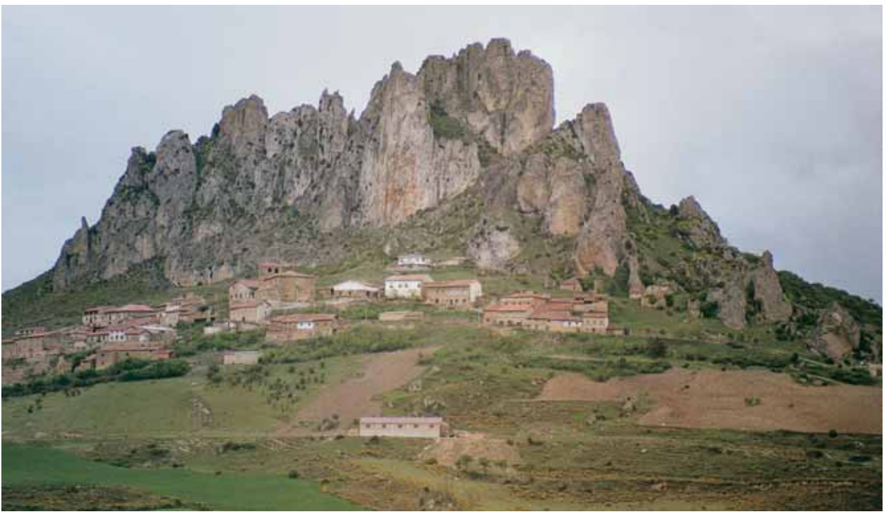
CELLORIGO, BALCON DE LA RIOJA
